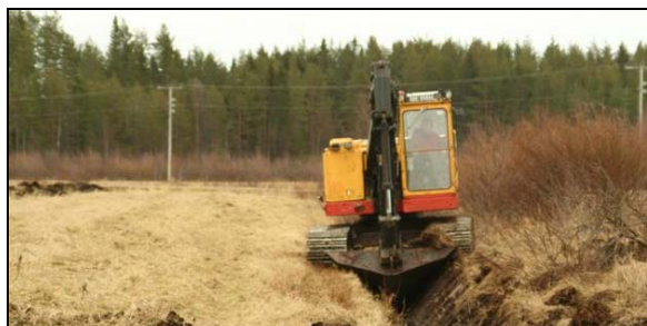
Grävmaskin med tegskopa
